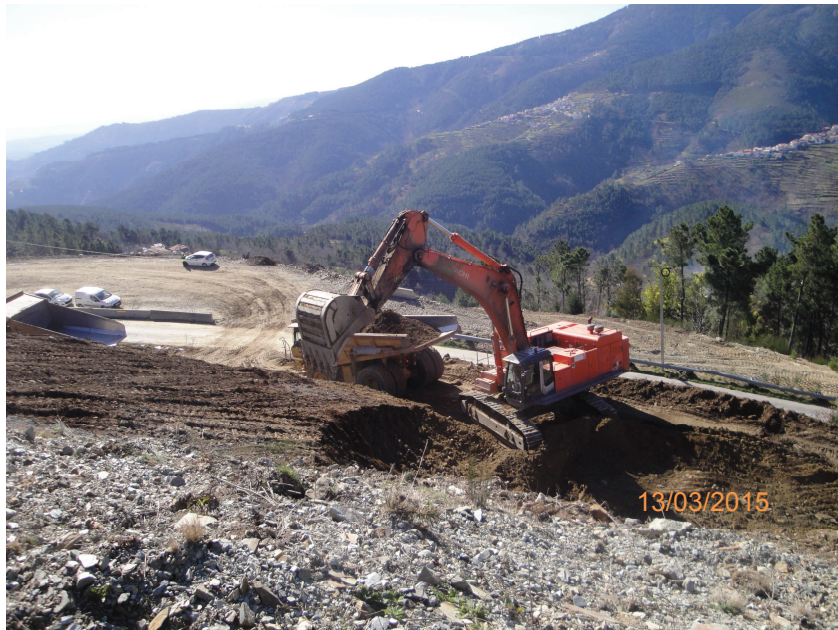
Registo Fotográfico 1 – Trabalhos de Escavação (Pk 20+100)
