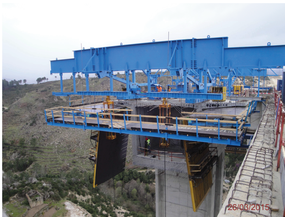
Registo Fotográfico 5 – Trabalhos em Obras de Arte (Viaduto V12)
