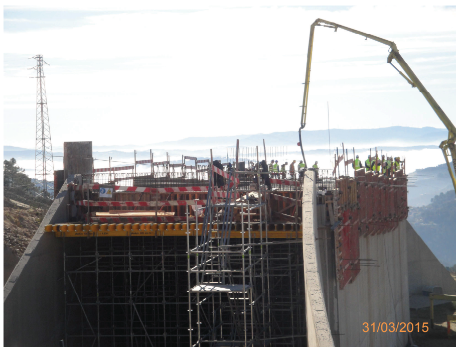
Registo Fotográfico 6 – Trabalhos em Obras de Arte (PI8)
