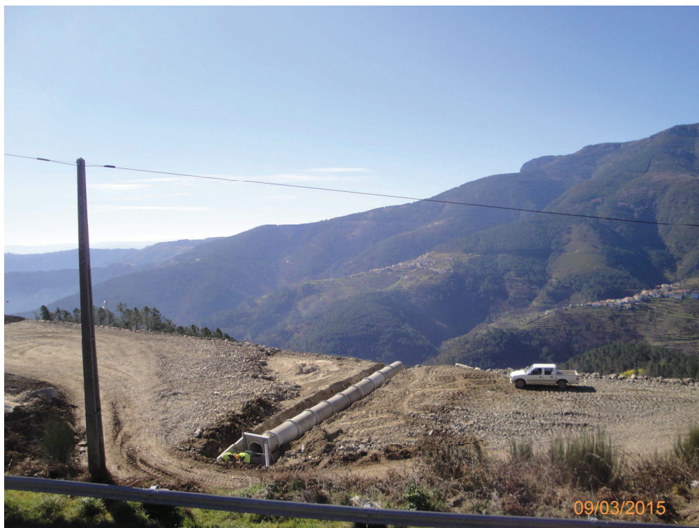
Registo Fotográfico 3 – Trabalhos de Drenagens junto ao Pk 20+400
