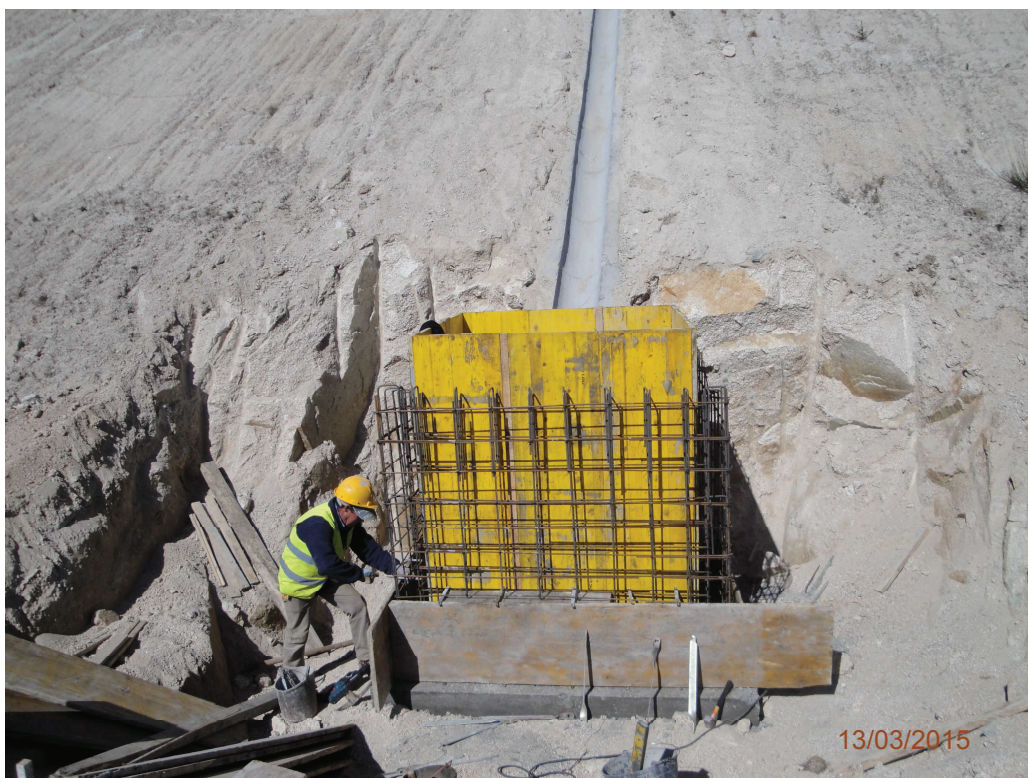
Registo Fotográfico 4 – Trabalhos de Drenagens (caixa visita) junto ao Pk 28+600
