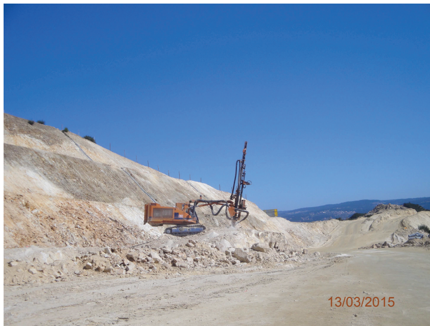
Registo Fotográfico 2 – Trabalhos de Escavação com recurso a explosivos junto ao Pk 29+200
